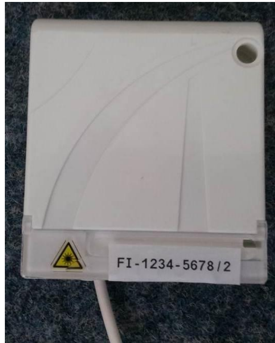
Figure 6 : repérage de la PTO déportée
