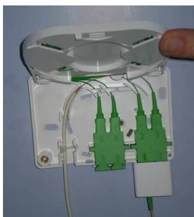
Figure 14 : arrimage du câble dans la prise
