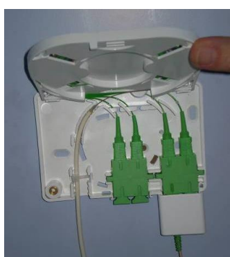
Figure 9 : arrimage du câble dans la prise
