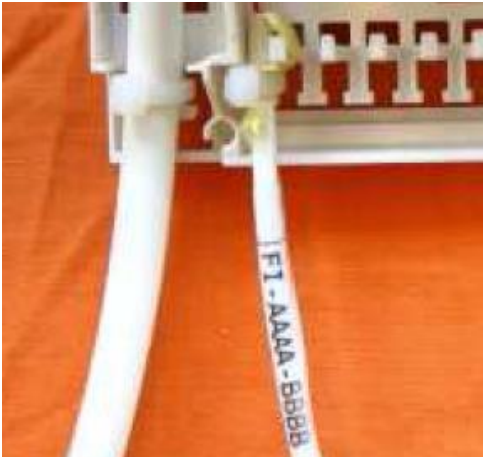
Figure 19 : exemple d'étiquette sur câble de branchement au niveau du PB
