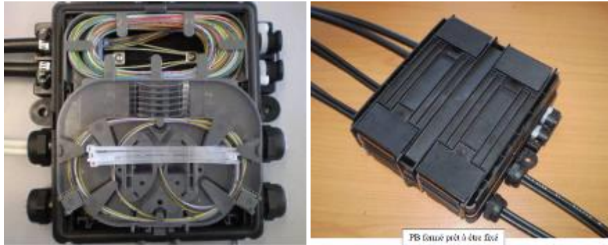
Figure 12 : Point de branchement en chambre, Nexans Black Box
