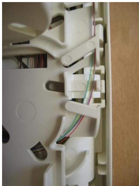
Figure 14 Arrivée en face avant des fibres à raccorder
