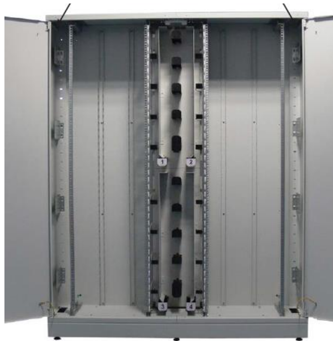
Figure 10. RTO en Armoire
