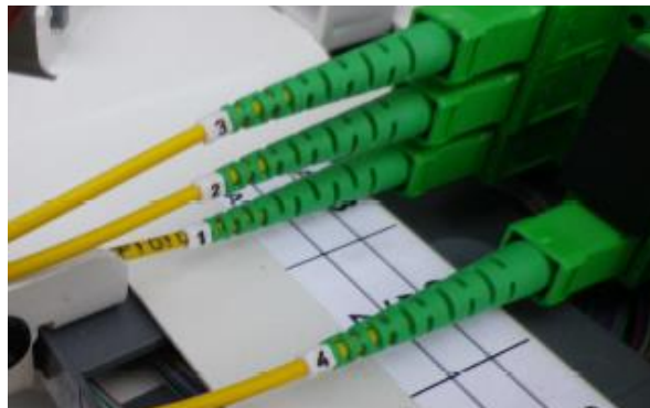
Figure 16. Exemple pose de cavalier sur cordon
