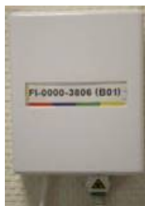
Figure 6 : FTTE passif au PM - exemple de PTO
