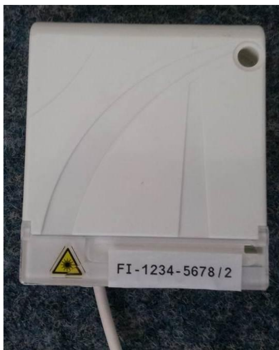
Figure 3 : repérage de la PTO déportée
