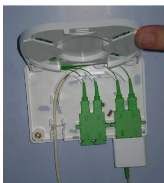
Figure 9 : arrimage du câble dans la prise
