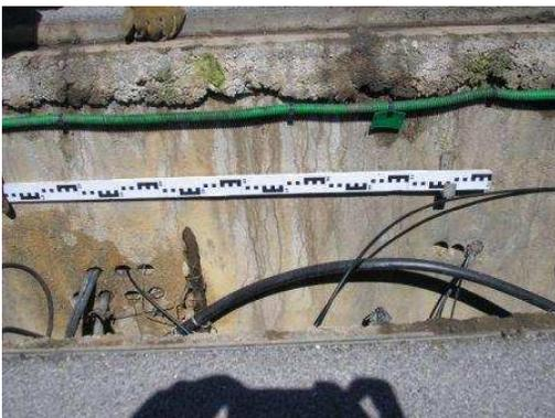
L'emplacement relatif à toutes demandes de pénétration de chambre (pour raccordement d'une chambre satellite ou d'une nouvelle conduite) doit également être matérialisé sur une photo.
