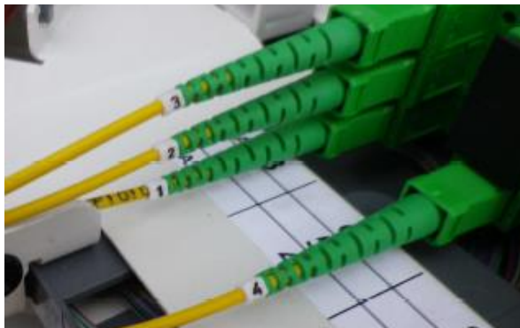
Figure 16. Exemple pose de cavalier sur cordon
