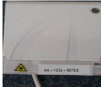
Figure 14: repérage sur la PTO déportée
