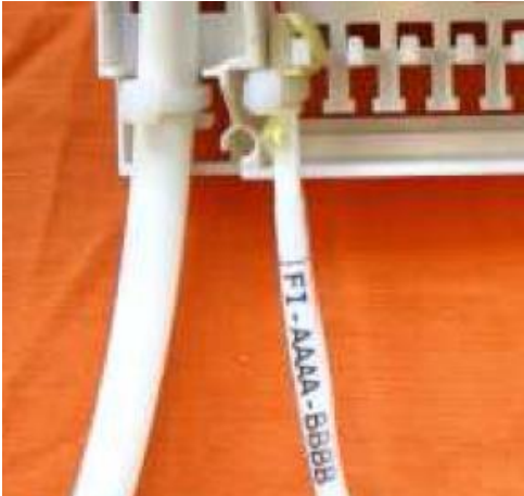
Figure 12 : exemple d'étiquette sur câble de branchement au niveau du PB
