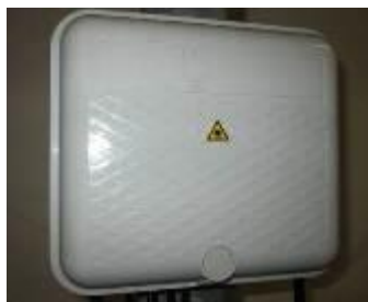
Figure 6 : Point de Branchement Optique, 3M Intérieur-extérieur
