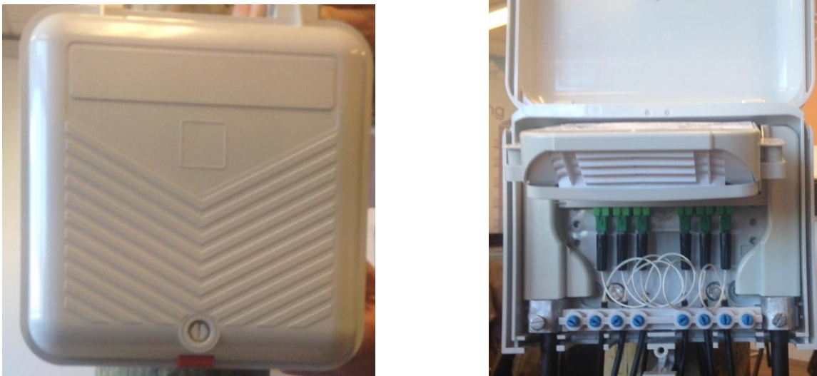
Figure 15 PB préconnectorisé 6 branchements maximum
